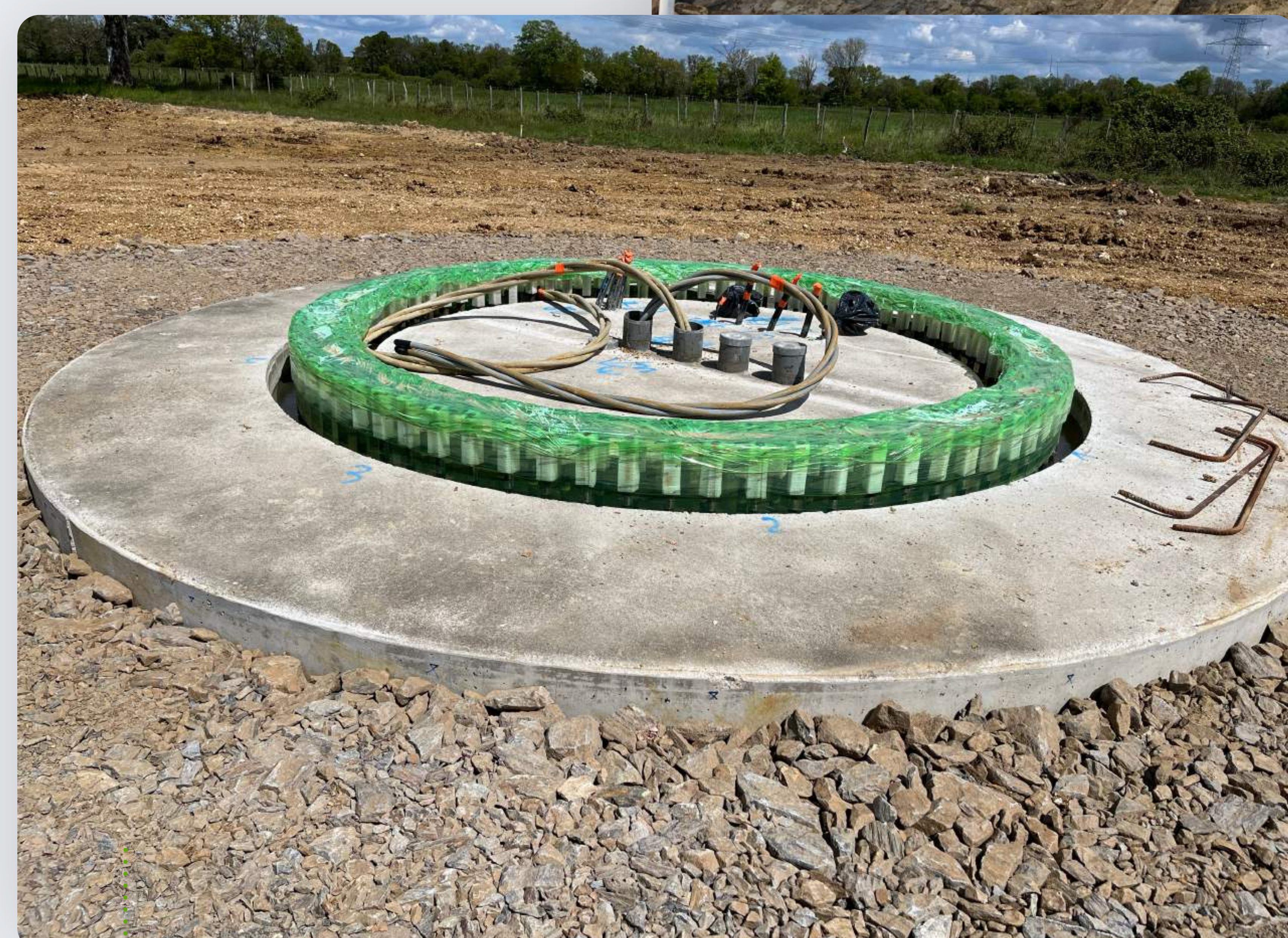
Fondation de l'éolienne après remblaiement
